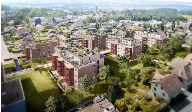
Illustration 11 : Lotissement Sentmatt, Obfelden (ZH) : L'électricité issue des capteurs hybrides est utilisée pour le fonctionnement de la pompe à chaleur et pour l'électricité des parties communes dans le cadre de la consommation propre. Source de l'illustration : Halter Immobilien AG
