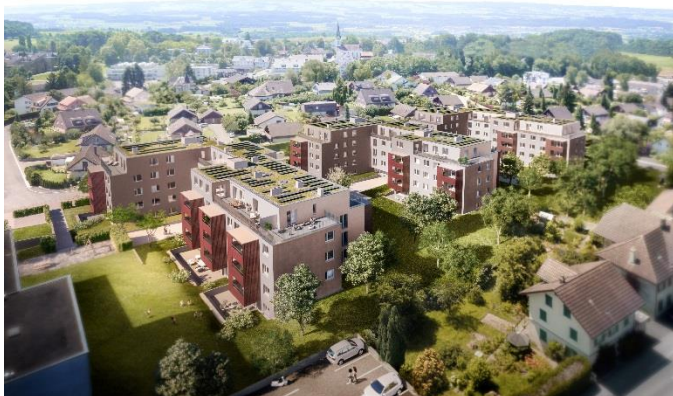
Figura 11: complesso residenziale Sentmatt, Obfelden: l'elettricità prodotta dai collettori ibridi viene utilizzata per l'alimentazione della pompa di calore e per l'elettricità delle parti comuni consumata in proprio. Fonte dell'immagine: Halter Immobilien AG
